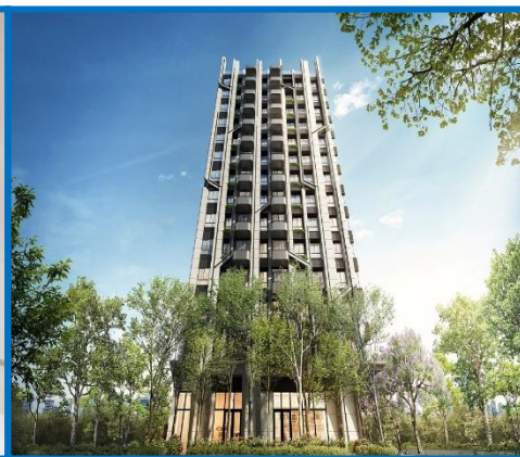
連麗軟橋段集合住宅全棟空調
